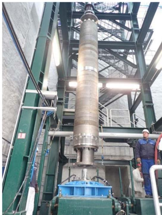
Abbildung 2: Einbau einer Tauchmotorpumpe am Standort Carolinenglück
